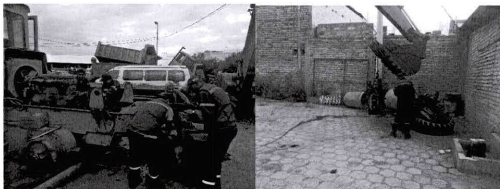
Fig. 3,4 Desmontaje de motor.
