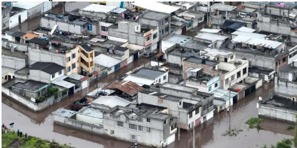
Imagen 13. Inundación del barrio Las Odilas en 2022, cantón Ibarra.
