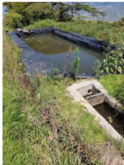
Imagen 10. Acumulación de agua en niveles internos debido a la filtración de agua de líneas de riego y reservorios.
