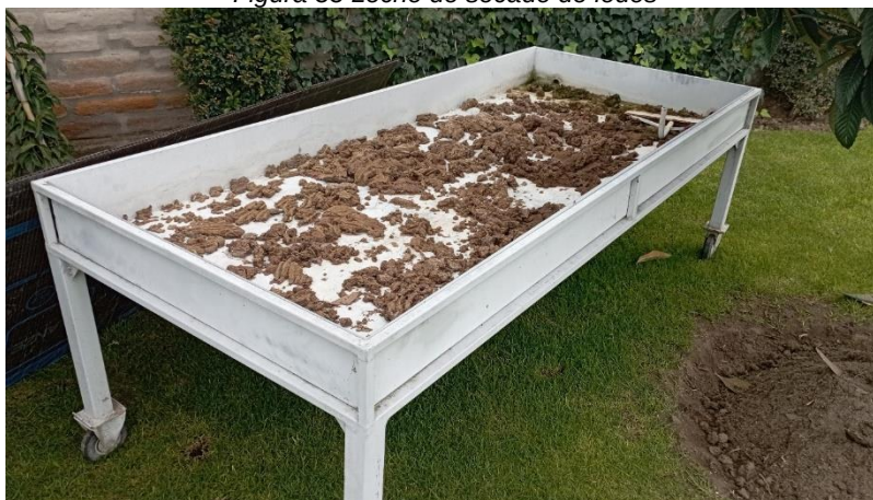
Figura 33 Lecho de secado de lodos
