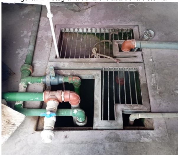
Figura 27 Fotografía de la entrada de la cisterna
