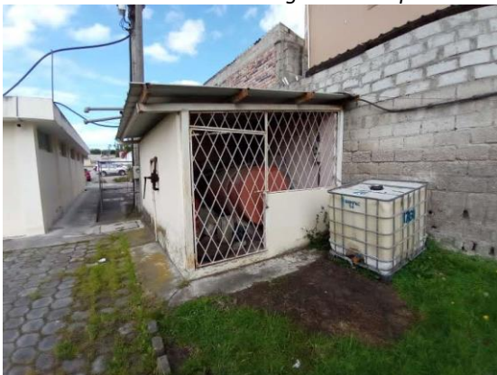
Imagen 17 Tanque de almacenamiento de combustible
