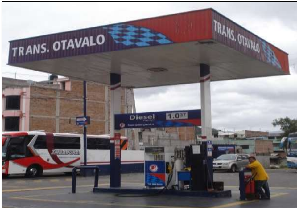
Foto No 1. Área de despacho
