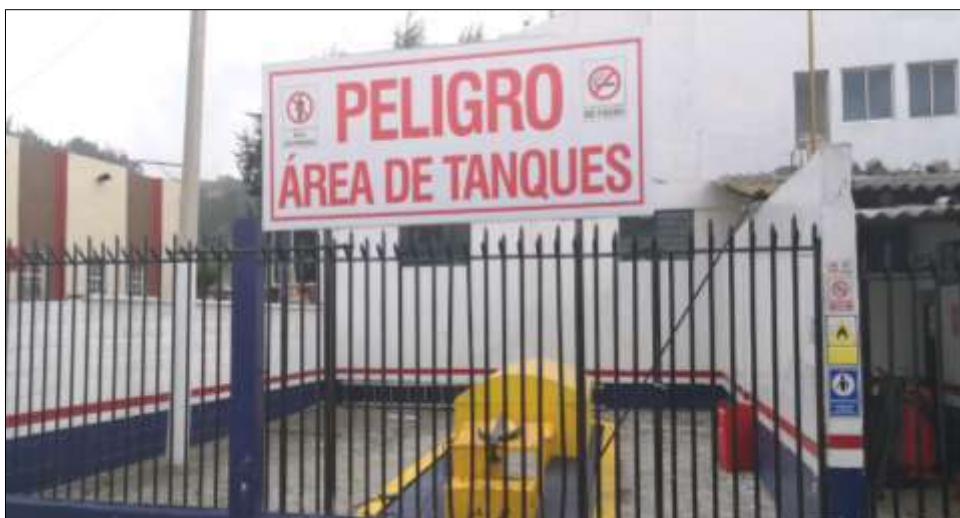
Foto No 4. Tanques de Almacenamiento del Combustible.
