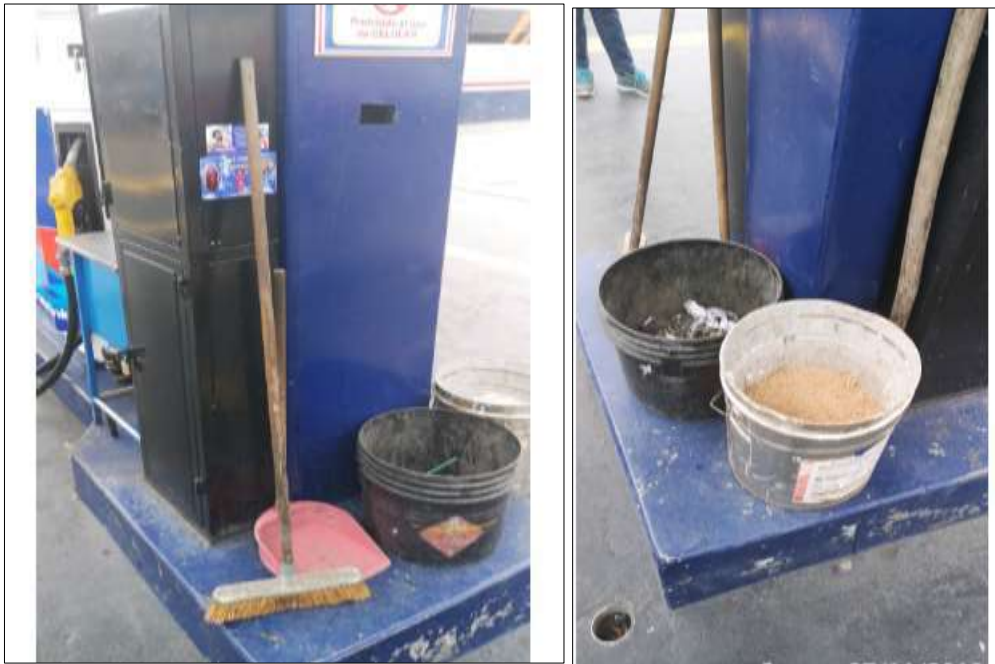
Foto No 25. Recipientes con arena para limpieza de derrames.
