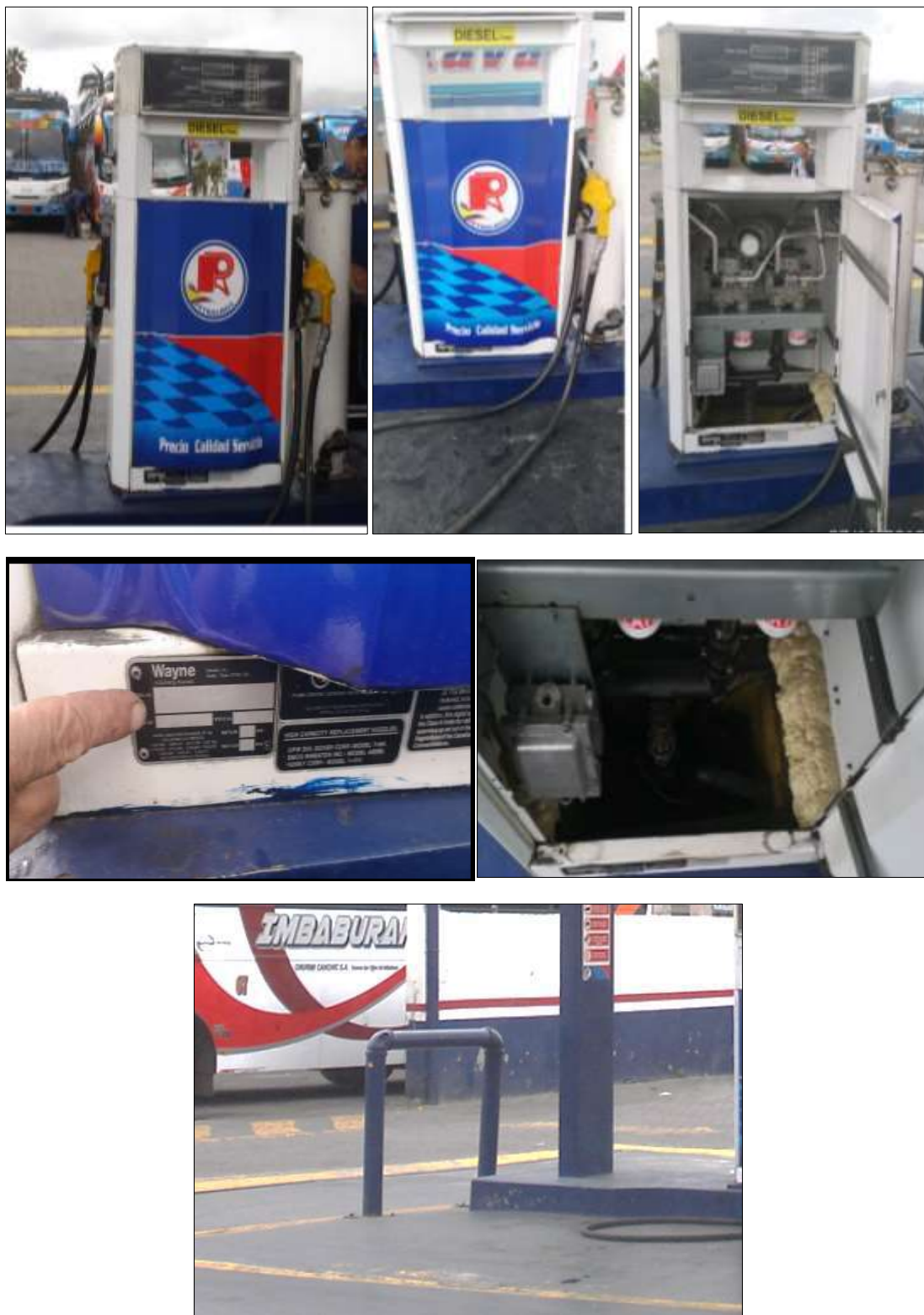
Foto No 2. Dispensadores. (Chasis metálico, placa de identificación, mangueras, pistolas, pantalla).
