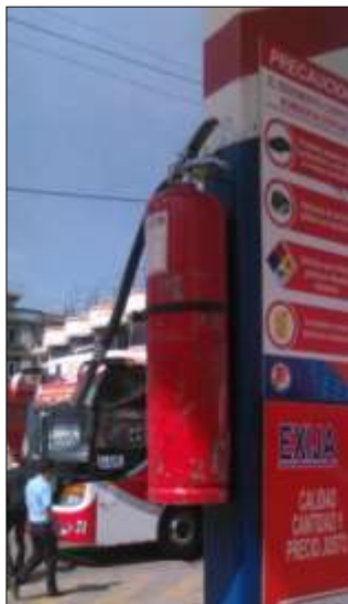
Extintores islas de despacho
