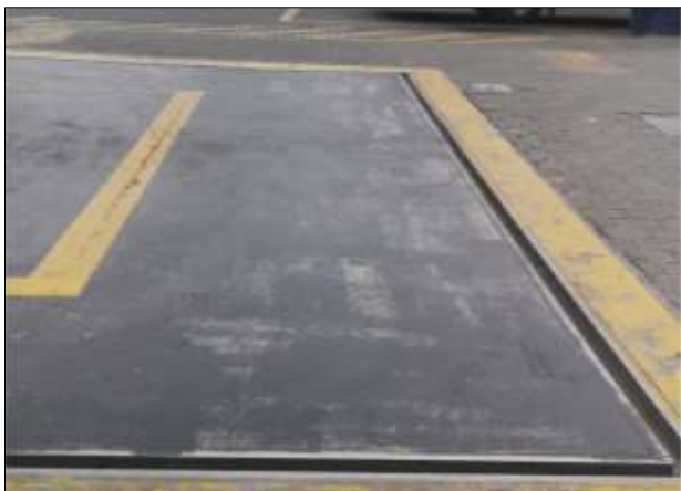
Foto No 9. Canaletas Perimetrales (área de descarga, área de despacho).
