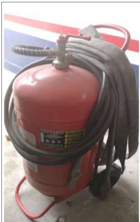
Foto No 8. Extintor y canaleta perimetral.
