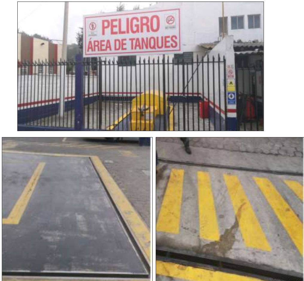
Foto No 5. Área de descarga de combustible
